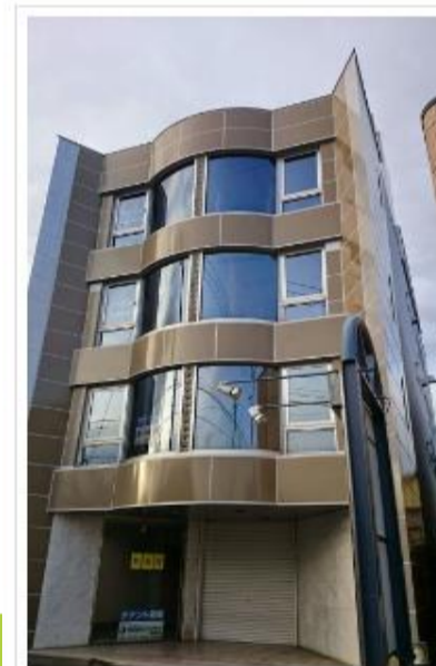
コーティング施工後
