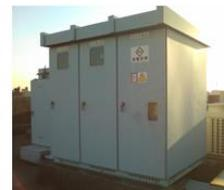
当社の無機ガラス質コーティングは海沿いの塩害地域に建設されている各発電所の・重防錆対応に効果を発揮しております。また、キュービクル・配電BOX等の外側に塗布することにより、耐熱効果を発揮し、受電・変電・配電設備への負荷を軽減します。
