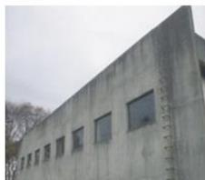
【コーティング前】風雨や排気ガスにさらされ、コンクリート表面が汚れ、劣化しています。
